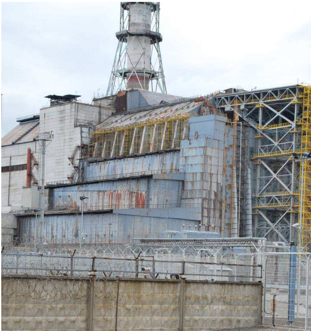
Sicherheits- Absperrungen; potentielles Materiallager für „schmutzige Bomben“
