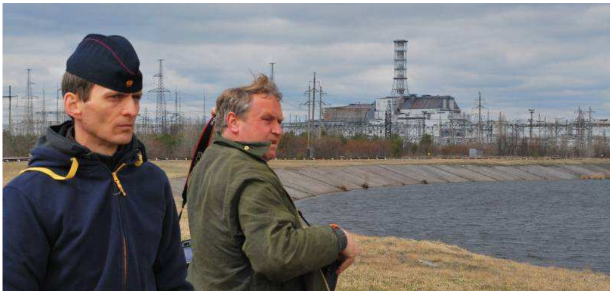
Im Kraftwerks- Park; vorn der Kühlwasserkanal, im Hintergrund das KKW- Reaktorgebäude.
