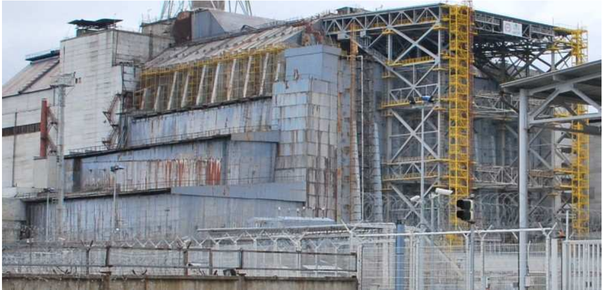
die im November '86 fertiggestellte Schutzhülle (Überdeckungsobjekt, vulgo „Sarkophag“)
